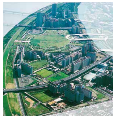
▲整備後の小松川地区
